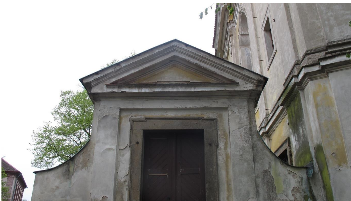
Příloha 39 – tympanon vedlejšího vstupu
