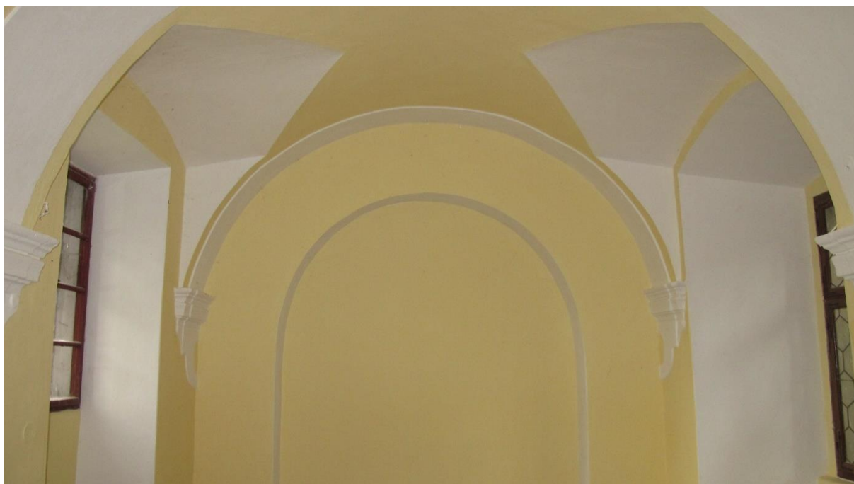
Příloha 8 – pohled do levé sakristie
